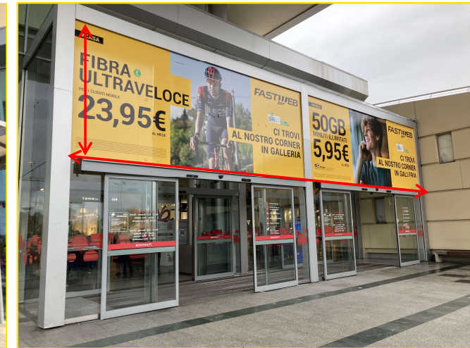
Vetrata ingresso Ovest
